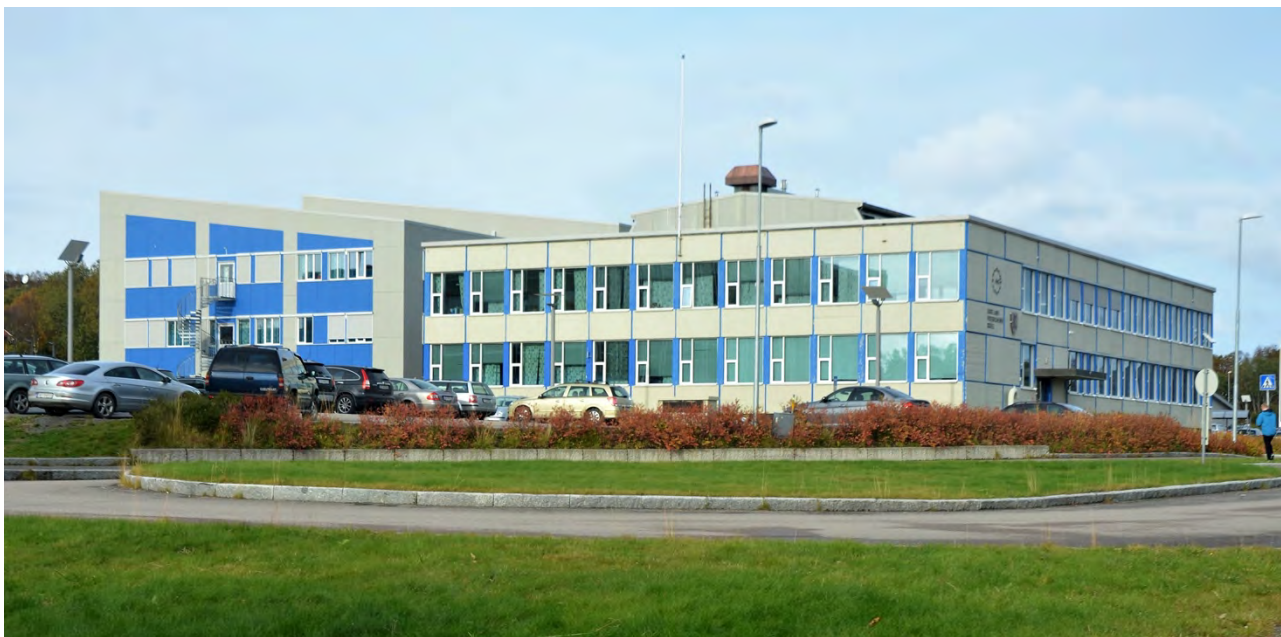
Fotografi 5: Sortland Gymnas fra sør, med ny og gammel del. Foto: Trond Gansmoe Johnsen.
